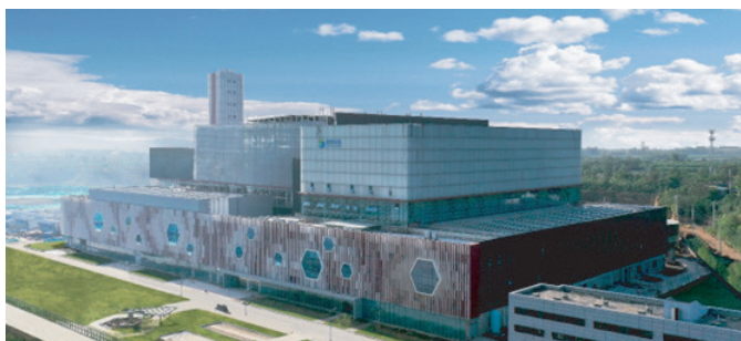
生活垃圾焚烧发电厂
